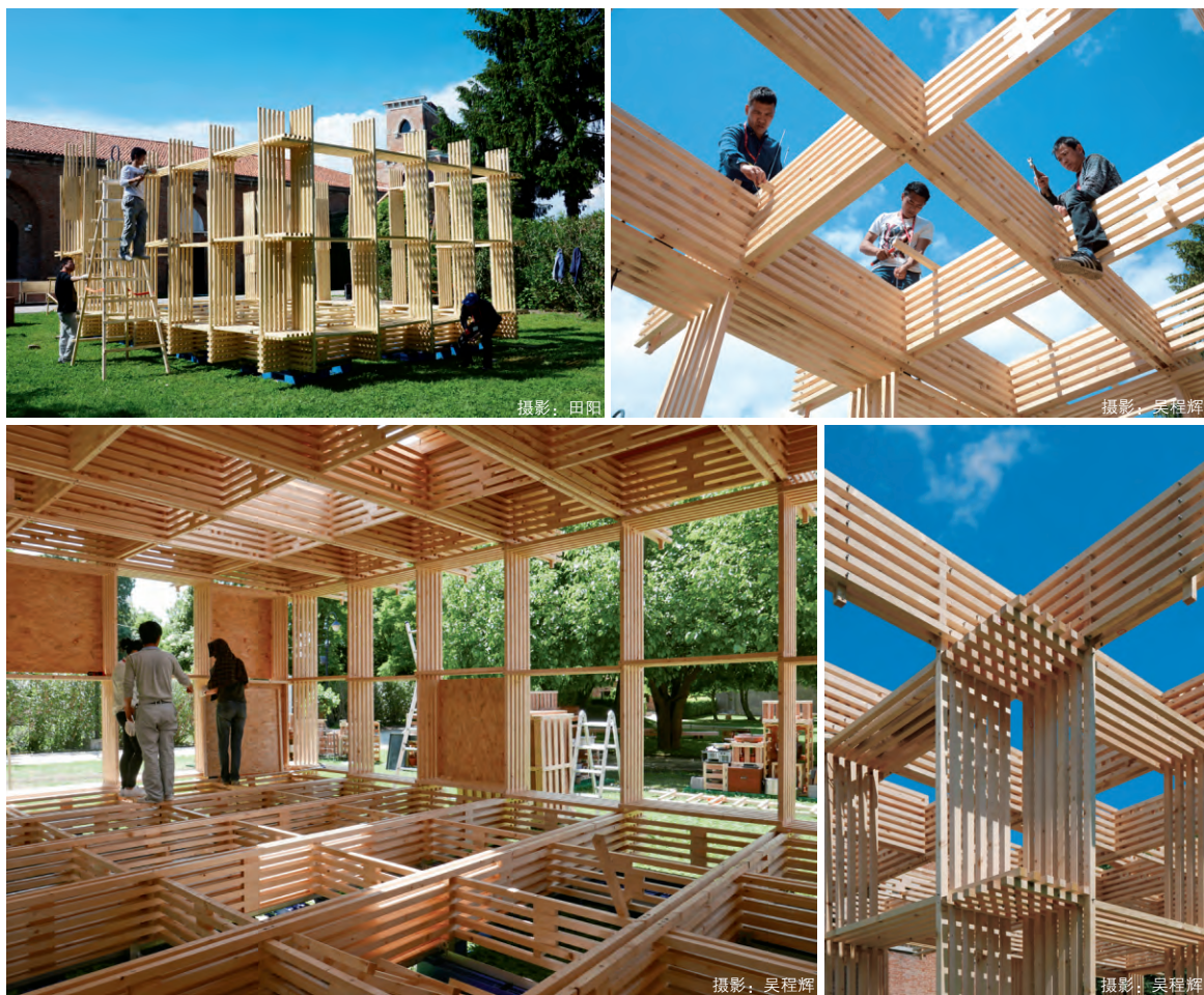
现场搭建过程
